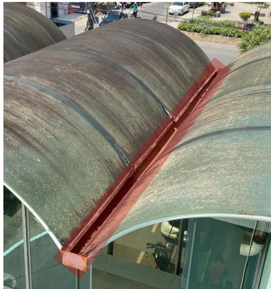
Figura 4: Identificação das calhas a serem retiradas
