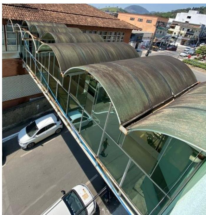
Figura 2: Abóbadas da cobertura a serem retiradas
